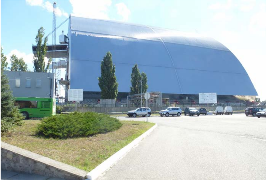
11 Der neue 'Sargdeckel', das 'größte verfahrbare Gebäude der Welt'
