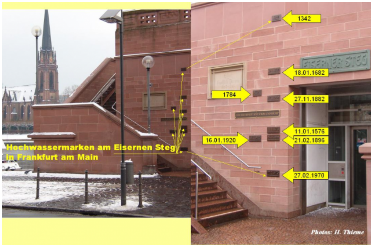
Bild 5 Hochwassermarken in Frankfurt a. M. Quelle: Historische Hochwassermarken
