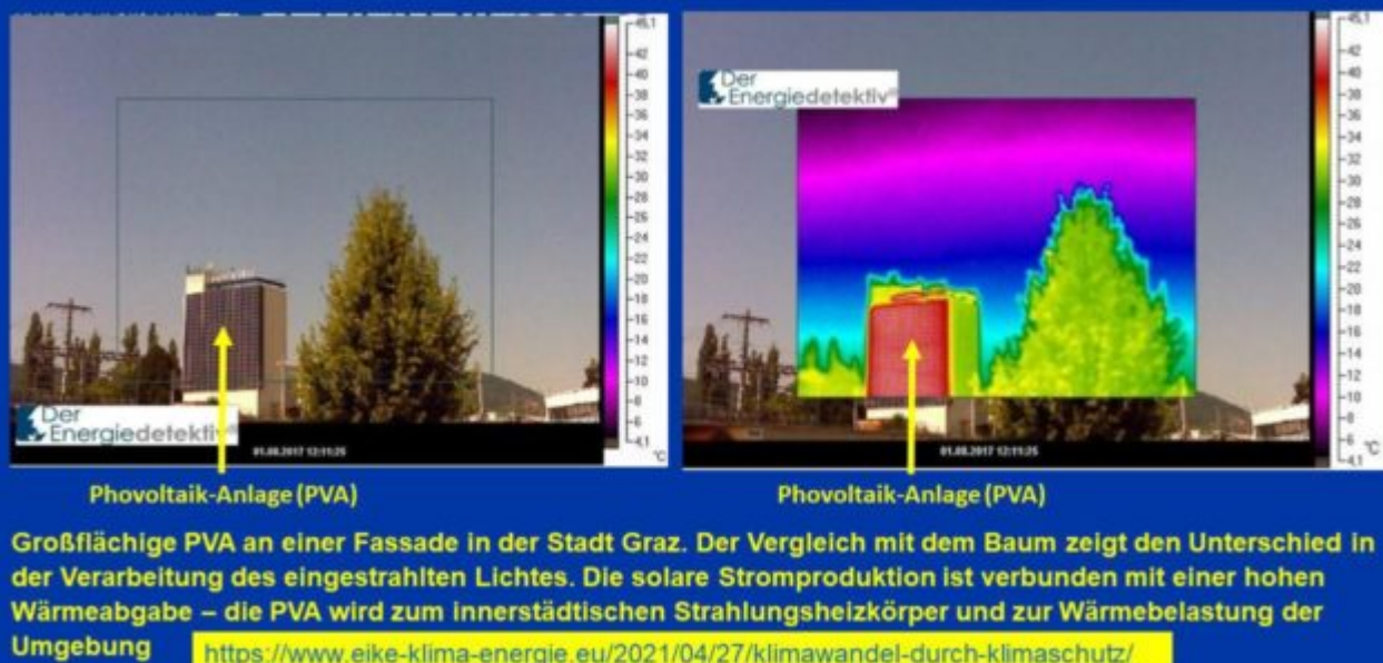
Abbildung 3: Photovoltaik-Anlagen werden zu innerstädtischen Strahlungsheizkörpern
