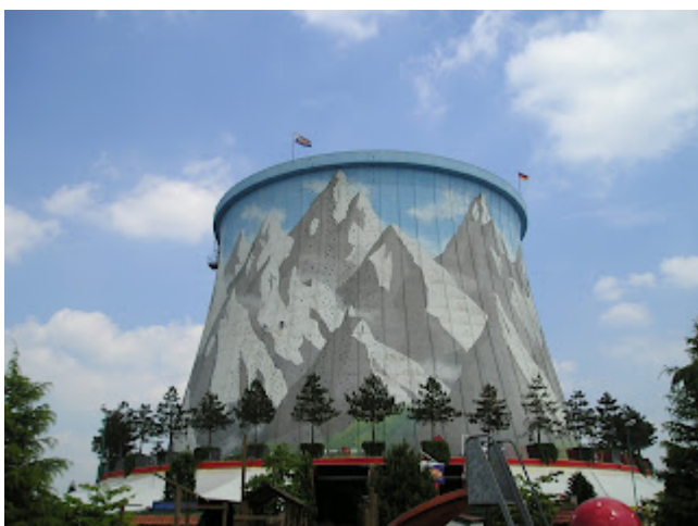
Der bemalte Kühlturm des SNR 300 in Kalkar als Klettergerüst
