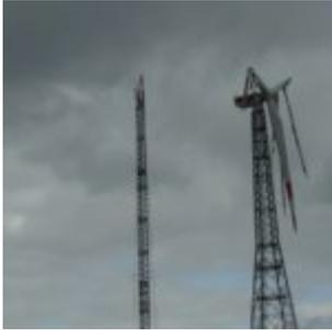
An der Bundesautobahn BAB A 9 bei Laubersreuth kann man gerade eine [ruinierte Windkraftanlage](#) besichtigen. Zwei Rotorblätter mit einem Gewicht von je 10 Tonnen sind zur Erde gestürzt bzw. haben sich um den Rotor gewickelt. Während eines nur mittleren Sturms mit einer Windspitze von 83 km/h wurde die vier Jahre alte Anlage von einer banalen Windböe im Februar geschrottet. Offensichtlich müssen die Lastannahmen für die Berechnung noch einmal erhöht werden und die Bestandsanlagen umgerüstet.
