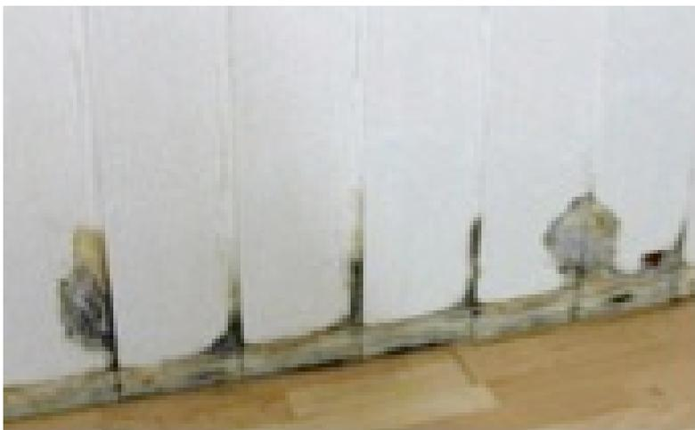
Massiver Schimmelbefall im feuchten Bereich einer Wandverkleidung
