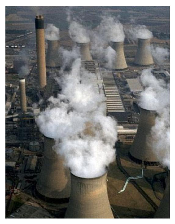
Abbildung: Die globale Erwärmung soll zum Teil durch das CO2-emittierende Verbrennen fossiler Treibstoffe verursacht worden sein. Diese Bild zeigt den Wrasen aus den Kühltürmen eines Kraftwerks. In den Medien oft und gern mit Rauch (die dünnen Rauchfahnen) aus den Schornsteinen verwechselt.
