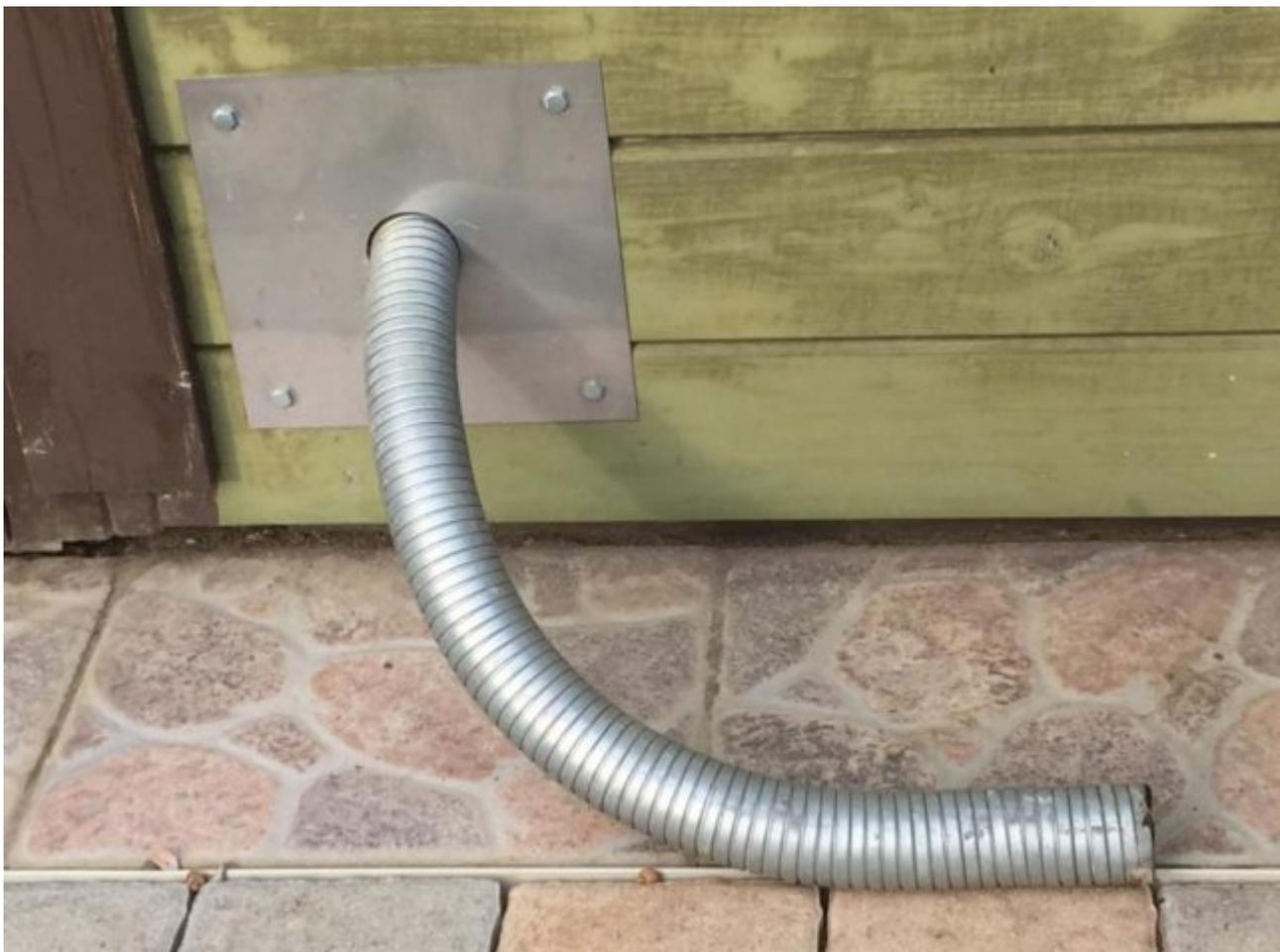
Bild 24: Durchleitung der Abgase eines Dieselaggregats durch eine Laubenwand mittels flexiblem Edelstahl-Abgasschlauch
