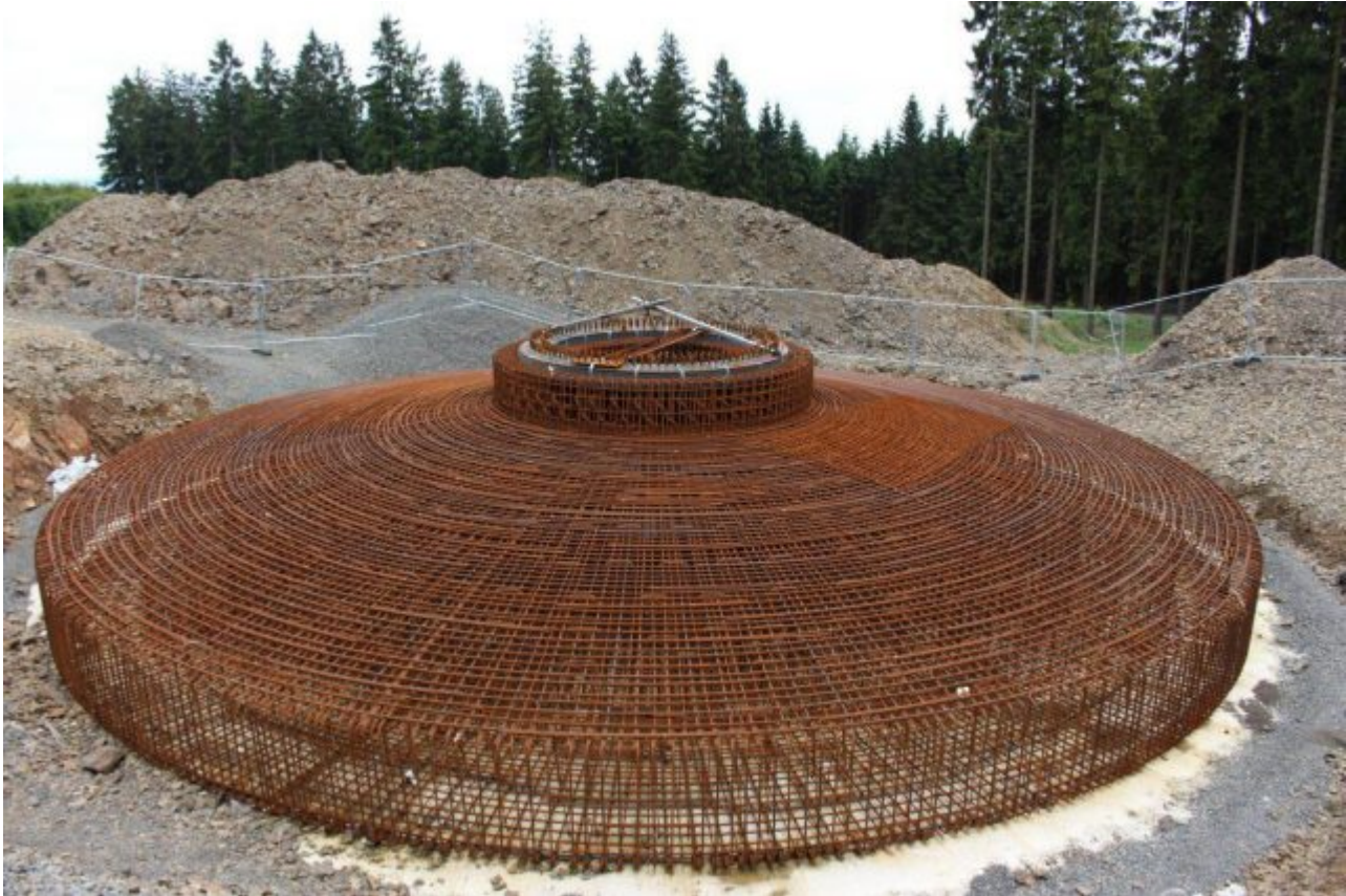
Bild 5 Foto: Alexander Blecher, Das Gesamtfundament hat ein Gewicht von 4000 Tonnen.
