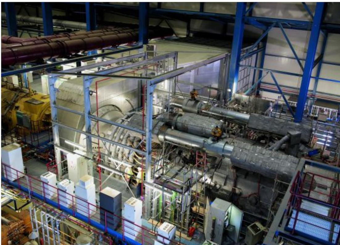
Die Turbine SGT5-8000H in Irsching wird in Verbindung mit einer Dampfturbine einen Rekord beim Wirkungsgrad aufstellen: mehr als 60 Prozent. Nirgendwo auf der Welt wurde dies bisher erreicht.
