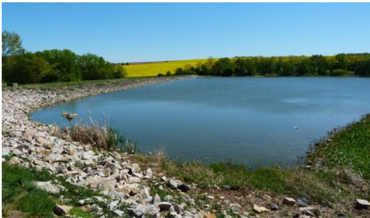
Abbildung 5: Kleinspeicher unweit von Kromsdorf bei Weimar; angelegt zu DDR-Zeiten und zur Bewässerung bis etwa 1990 genutzt. Nebenbei entstand ganz ohne grüne Ideologie ein Biotop mit Libellen und anderen Wasserinsekten, Fischen, Amphibien und Wasservögeln. Links im Bild die Staumauer. Foto: Stefan Kämpfe
