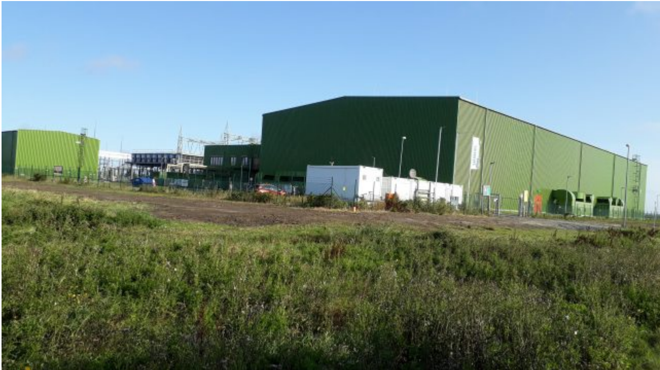
Konverterhalle, Enden-Ost, von hier soll die HGÜ A – Nord bis Kaarst verlaufen, Foto: Bernd Kehrmann
