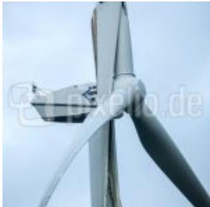
Die Konzepte dafür sind die Hersteller größtenteils noch schuldig. Während die Beton- und Metallteile wie Turm und Generator sich recht einfach verwerten lassen, sind die aus Kunststoffen gefertigten Rotorblätter eine echte Herausforderung. Denn diese enthalten Gifte.
