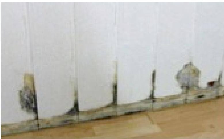
Massiver Schimmelbefall im feuchten Bereich einer Wandverkleidung
