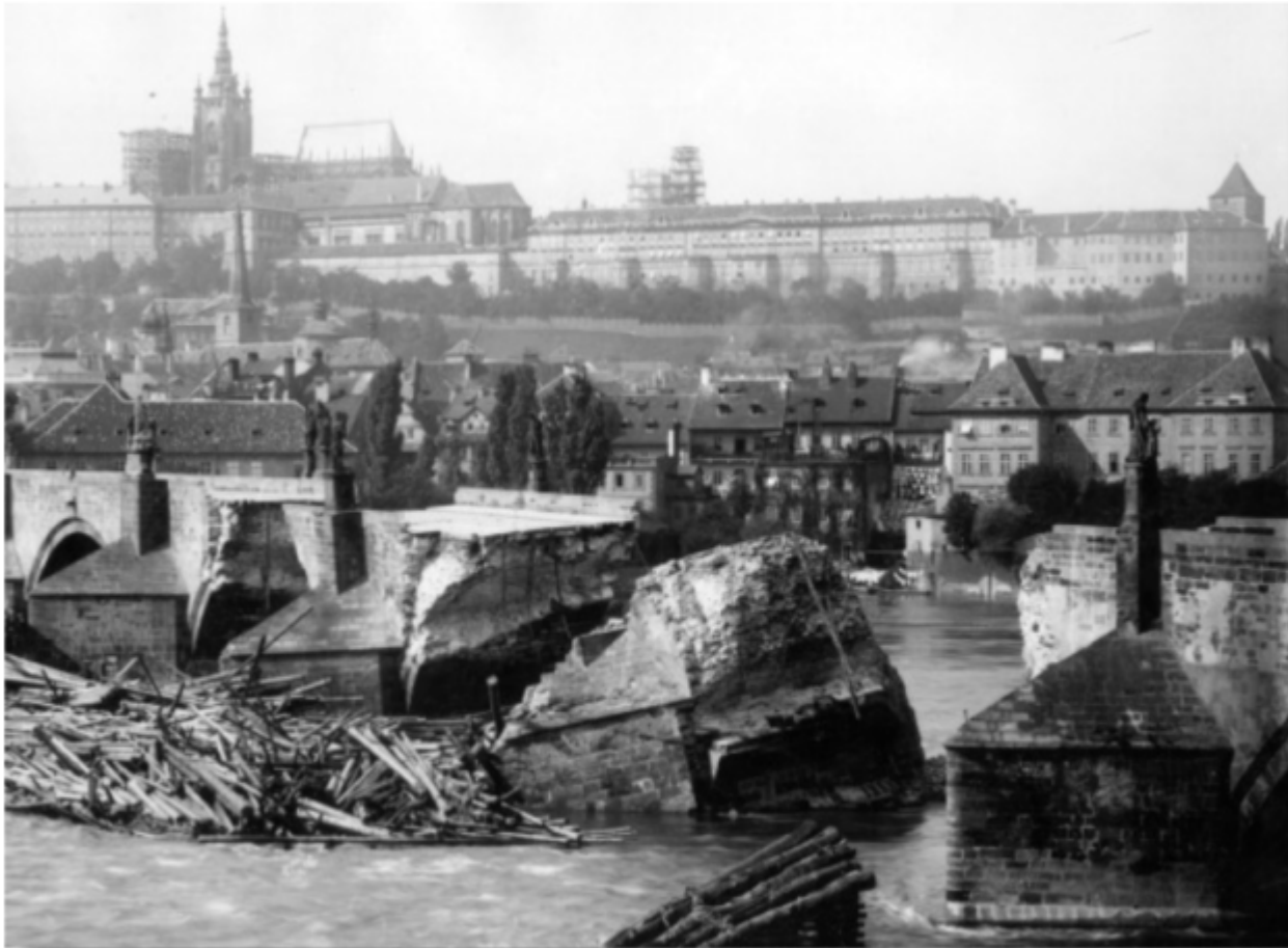
Die Karlsbrücke nach dem Hochwasser am 4. September 1890. Vor der Brücke haben sich große Mengen Treibholz angesammelt. Drei Bögen sind eingestürzt.
