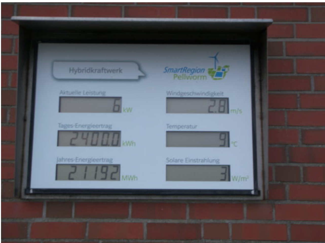
„Wasserstandsmeldung“ der aktuellen Einspeisung. Bild P. Würdig
