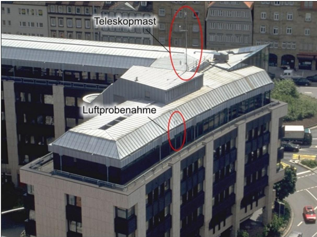
Abb.6 zeigt die Stuttgarter Feinstaubmessstation in Stuttgart Schwabenmitte. Dort werden in der Luft die folgenden Parameter gemessen, Quelle:
