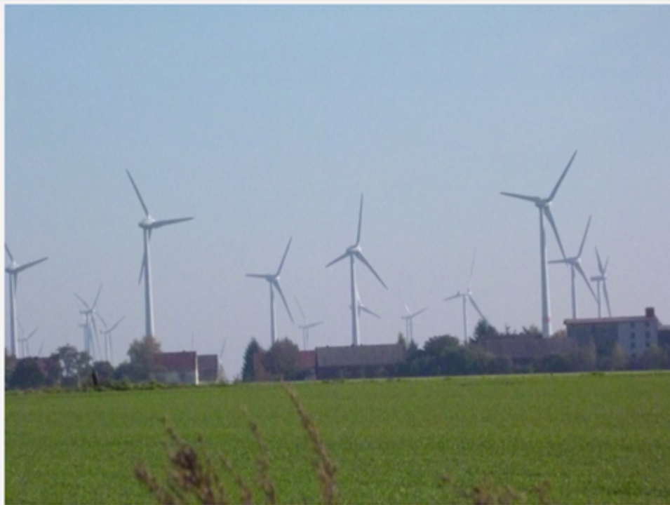
Willkommen im Endstadium dieser Energiewende: 43 Windkraftanlagen und (noch) 130 Menschen bevölkern das energieautarke Feldheim.
