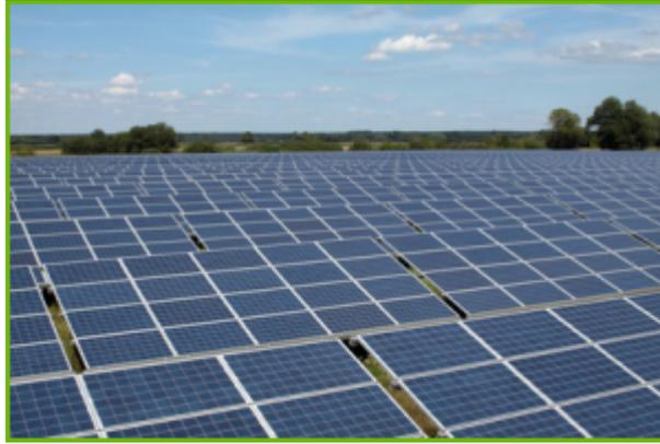
*Abb. 18 und 19: Während besonders reife Getreidefelder hell aussehen (sie reflektieren einen Großteil des einfallenden Sonnenlichts und bleiben dadurch relativ kühl), sind Solarpaneele sehr dunkel. Sie wandeln nur etwa 10% der einfallenden Sonnenstrahlen in elektrische Energie um, absorbieren aber den übrigen Teil fast ganz, was sie und letztendlich auch ihre Umgebung stärker erwärmt. Bildquellen: thumbs.dreamtime.com (Getreide) und energiepoint.de .*
