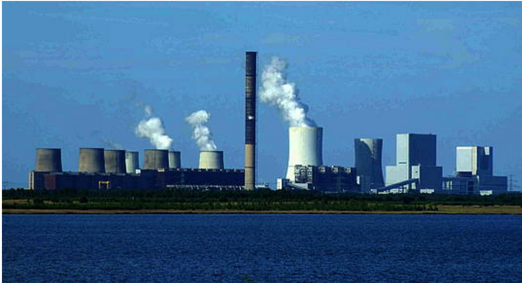
Bild 4. Großkraftwerke wie das 2575-MW-Braunkohlekraftwerk Boxberg kann man nicht einfach an- und abschalten wie ein Auto (Foto: Kohlekraftwerke.de)
