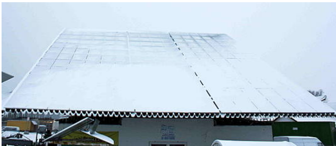
Bild 3. Eine solche Bedeckung durch Schnee und Eis – hier in Bayern im Frühjahr 2013 – drückt den Ertrag der Anlage auf nahezu Null
